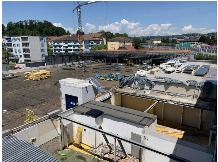
↑ Baustelle Distributionszentrum Galexis Lausanne-Ecublens
